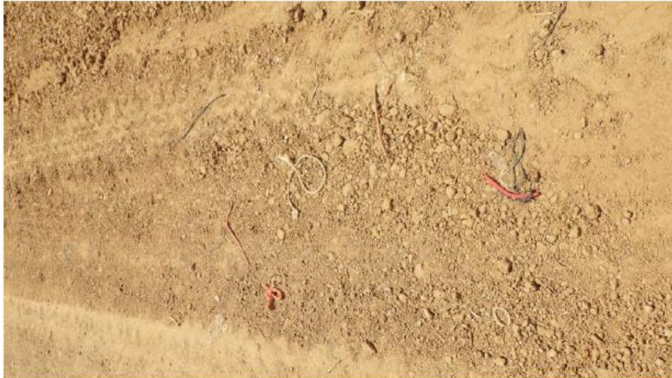
פני דרך עם חומר חופשי ופסולת – לא קביל לטיפול מונע אבק טבלה 5: סוגי חומרים למבנה דרך המשפיעים על אורך חיי הדרך והטיפול באבק
